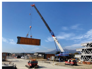
一种利用绳索引导悬吊荷载的装置“EG-Guide”
